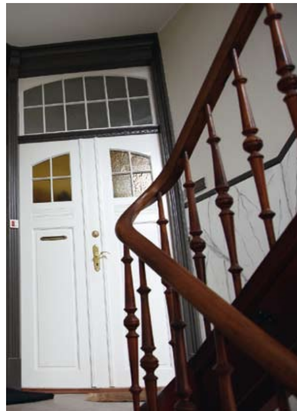
Renovering af trappeopgang i Ørstedsgade, Vejle.
