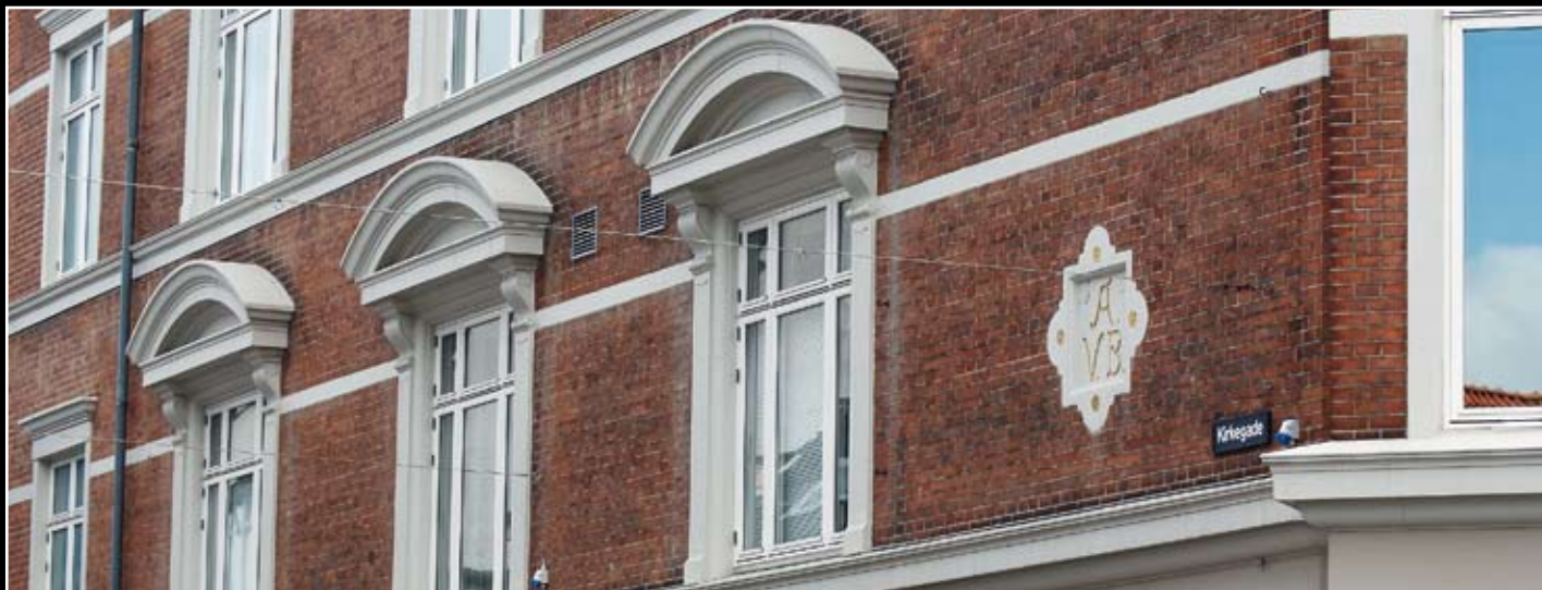
Facaderenovering, Kirkegade i Vejle.
